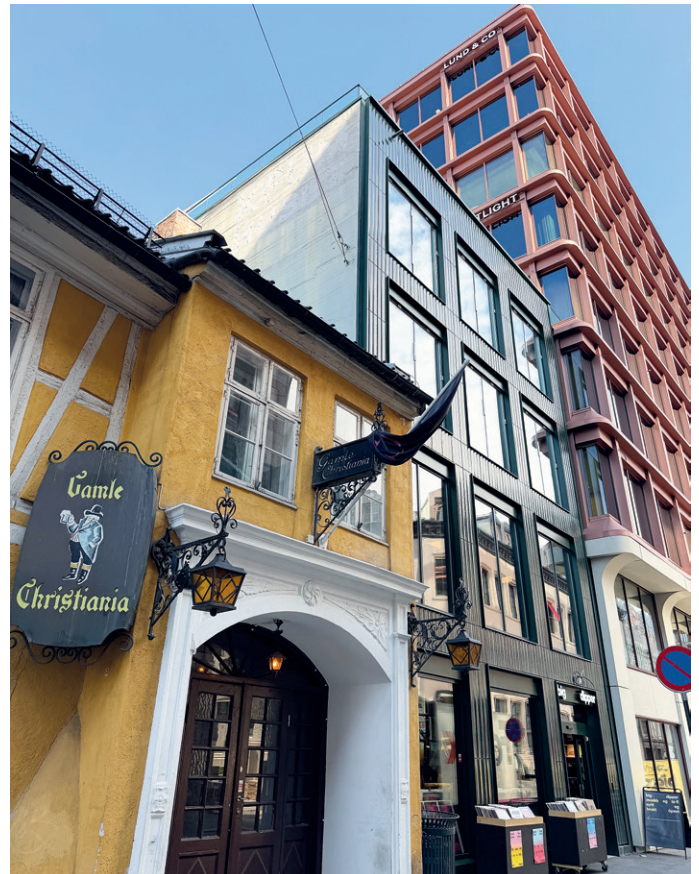
Den lavere delen av bygget fungerer som et «mellombygg», og har fått en grønn fasadekledning.
