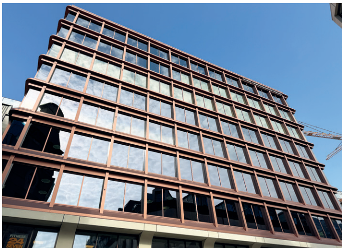
Bygget fra 1960-tallet, tidligere kjent som KFUM-huset, har gjennomgått en omfattende modernisering.
